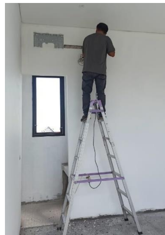
(d) Pemasangan AC Baru
